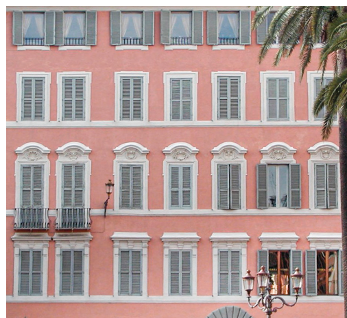
Fig. 10: Facciata dopo il tinteggio ai silicati. Rosa freddo causato dall'uso del biossido di titanio
